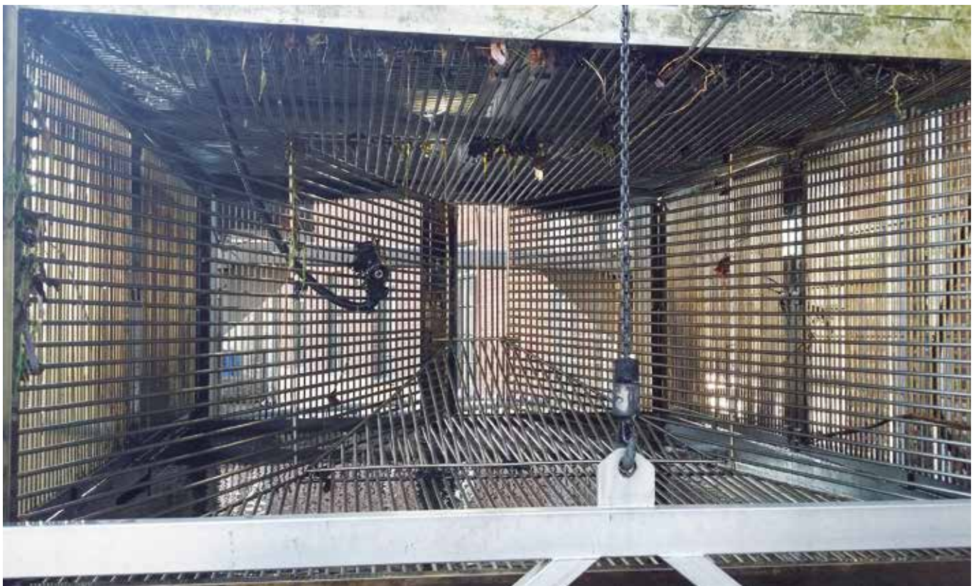
Fangkammer für im Oberflächenwasser absteigende Smolts
