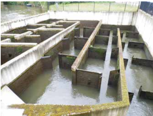
Fischstufe an der ECI, Roermond (Wasser abgelassen)
